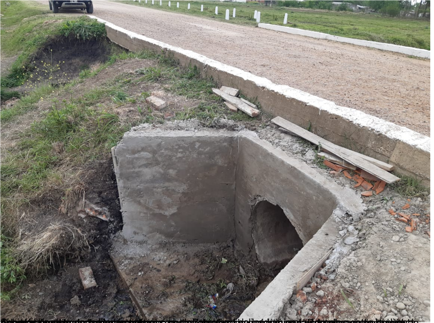
Se muestra el avance de las obras de las alcantarillas de la plaza y de la zona de la plaza de la feria, la
